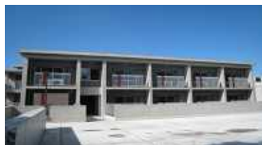
【西部構内ボックス棟】
