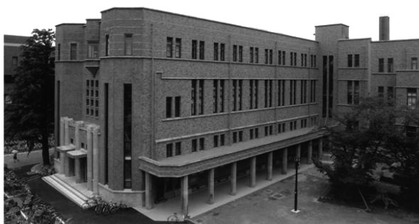
総合研究棟(法経本館)
