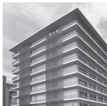
新病棟「積貞棟」
