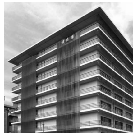
新病棟「積貞棟」
