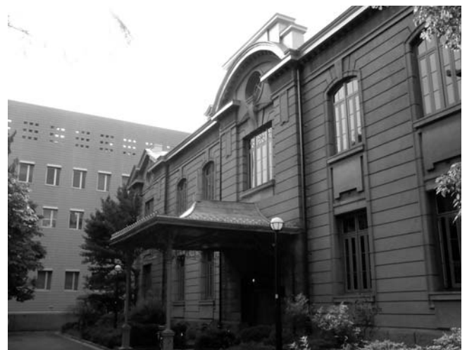
耐震機能改修を行った文学部陳列館
