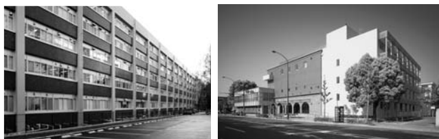
耐震機能改修工事を行った農学部総合館 (写真左) と西部総合研究棟 (写真右)
