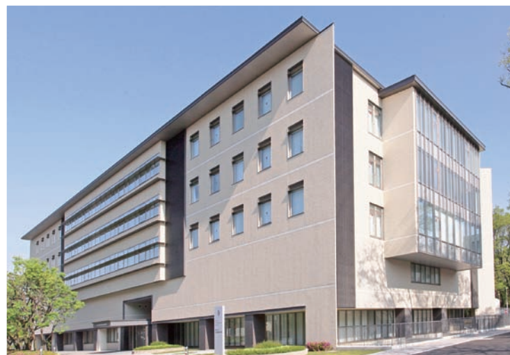
iPS細胞研究所研究棟 竣工
