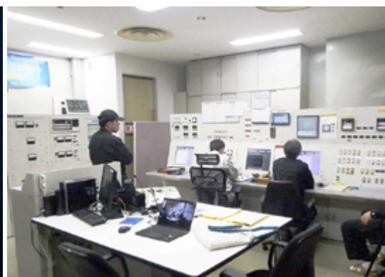
KUR 運転中の制御室の様子
