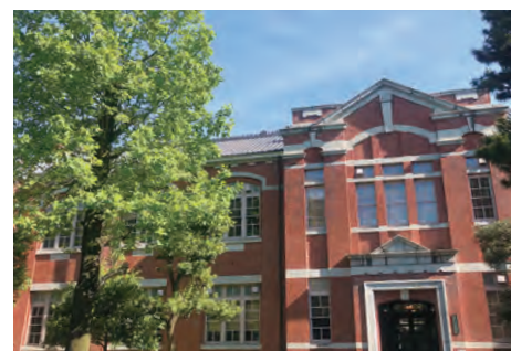
総合研究14号館(旧土工学教室本館)
