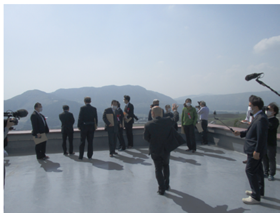
センター周辺の復旧工事見学の様子
