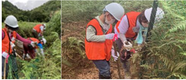
<新しい植生保護柵を張り替える作業>
