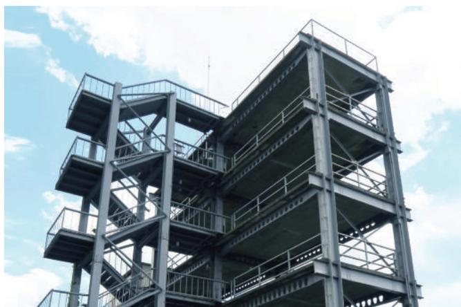
宇治キャンパス(防災研究所 鋼構造実大試験架構)
