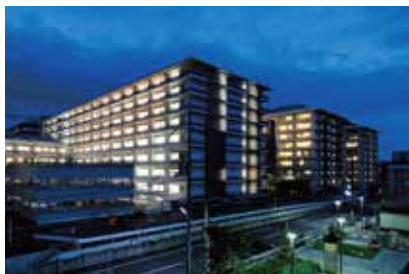
中病棟外観(北西側より)
