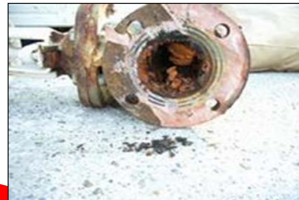
給水管の老朽化により赤水が発生
