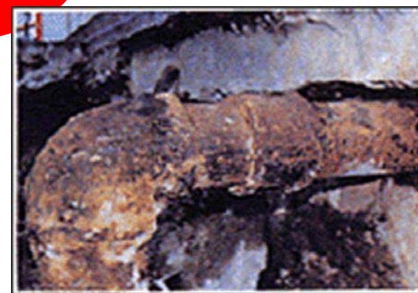
老朽化したガス管
