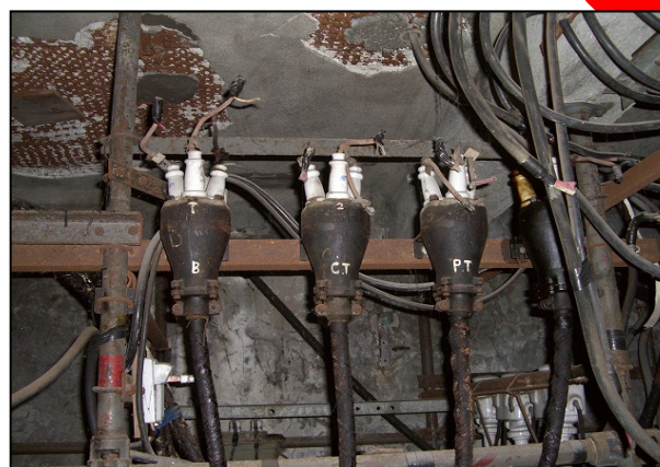
老朽化した変電設備
