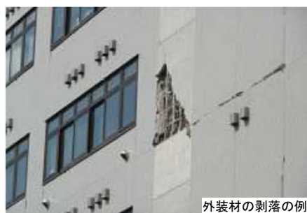
外装材の剥落の例
