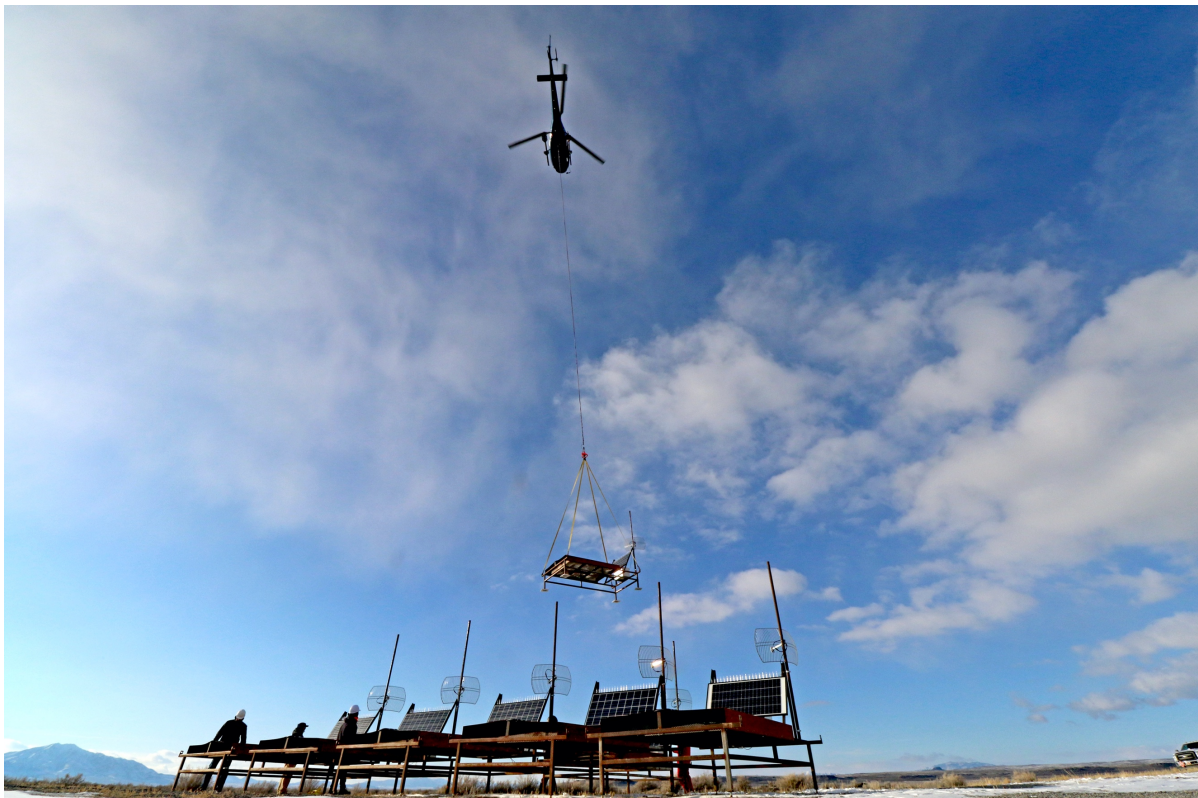
図 4 テレスコープアレイ実験の拡張計画のために製作し、設置を待つ地表粒子検出器（上写真）。ヘリコプターによってアメリカユタ州の砂漠地帯へ設置される地表粒子検出器（下写真）。
