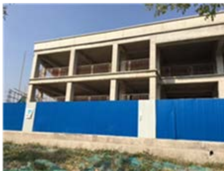
低層建物外観
