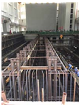
振動台建設現場
