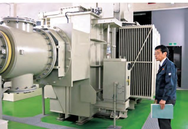
77,000Vの高圧電力を受電し、降圧する装置。地下の約300㎡ほどの広い空間に配置されている
