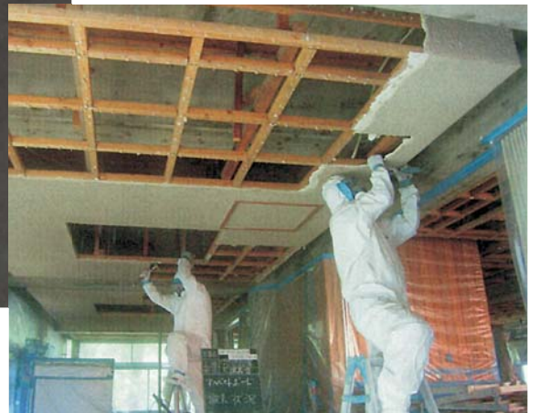
土木総合館における吹き付けアスベスト除去作業。1989年には、京都大学の「アスベストによる環境汚染対策指針」が示された。
