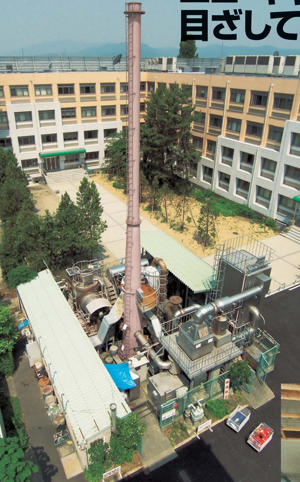
ダイオキシン分解のために設置された触媒分解塔。排ガスの高度処理技術により、水蒸気による白煙は発生しない。部局によって処理日が決まっている。
