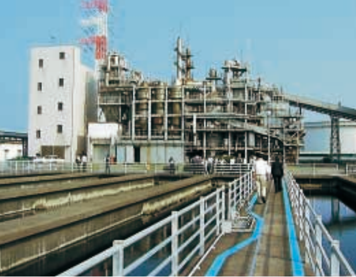
↑先生が基本設計をした茨城県鹿島の下水汚泥焼却炉。手前で下水を処理し、奥の建物で下水汚泥で脱水、焼却する。
