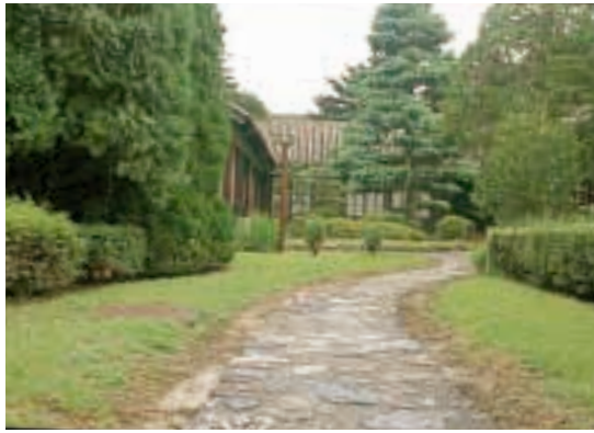
▶1931（昭和6）年建築の旧本部署務室。木造建築であるが、当時のヨーロッパの考え方を巧みにとり入れ、周囲の景観とも調和している。京都帝国大学営繕課の大倉三郎の設計
