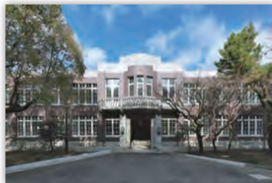
総合研究15号館（旧建築学教室） 外観
