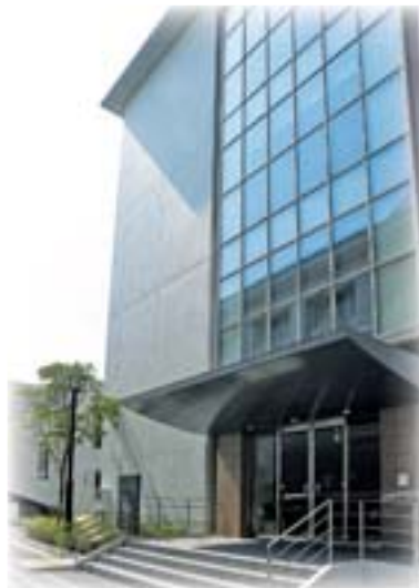
物質－細胞統合システム拠点研究棟
