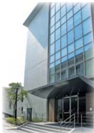
物質-細胞統合システム拠点研究棟
