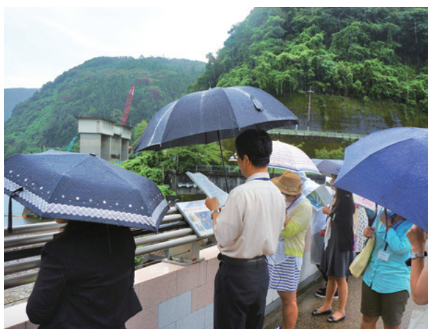
天ヶ瀬ダムの説明の様子
