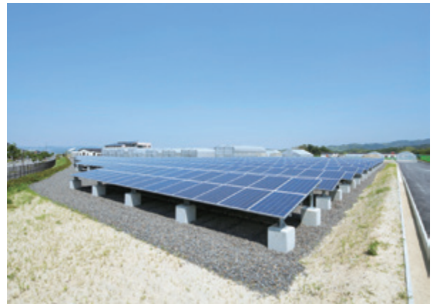
太陽光パネル
