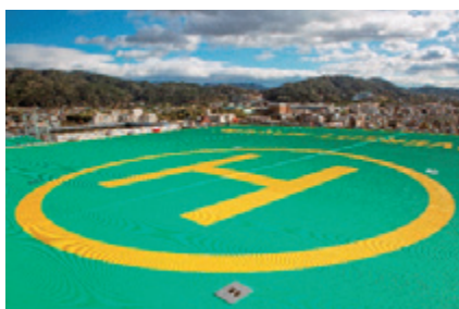
新病棟屋上ヘリポート
