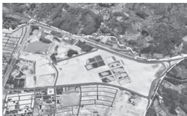
木津川新農場(中央部分)上空写真
