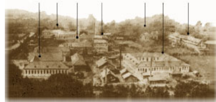
1897(明治30)年、法・医・文・理工の4分科大学で構成さ れる総合大学として京都帝国大学が創設され、まず理工科 大学が設置された。
