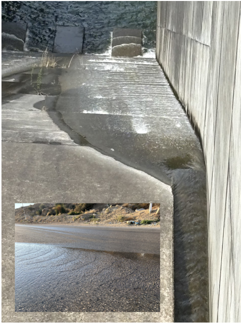
蔵王ダム（日野川流域土地改良区）とヨルダン王国カラク県の道路で見られた転波列（宇波撮影）
