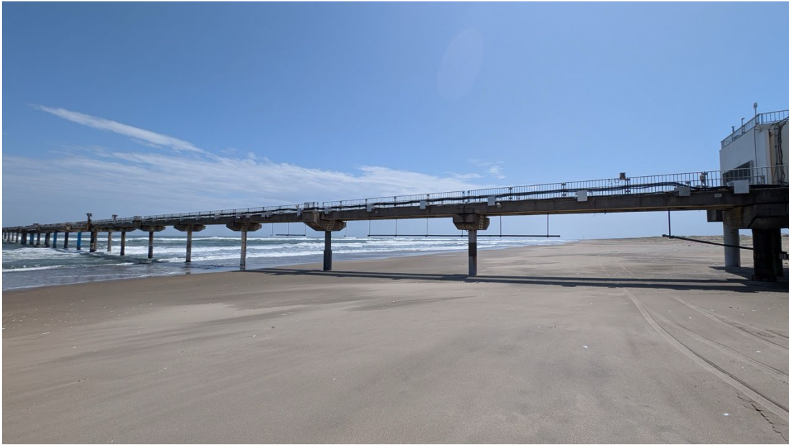
図 1 波崎海岸の観測棧橋
