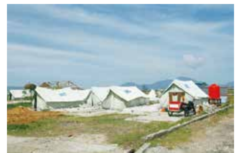
国際機関からの援助で設置されたテント村 (2004年インド洋津波災害、バンダ・アチェ、インドネシア)
