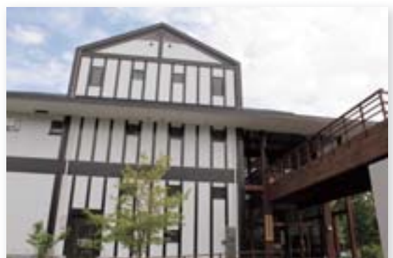
木質材料実験棟【木質ホール】
