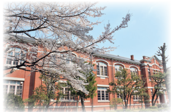
工学部土木工学教室本館
