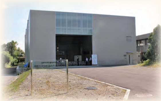
高度マイクロ波エネルギー伝送実験棟
