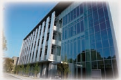
宇治地区先端イノベーション拠点施設
