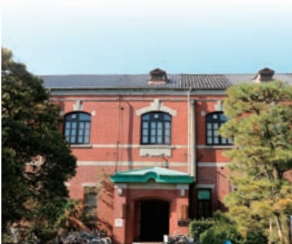
旧石油化学教室本館 (学務部)
