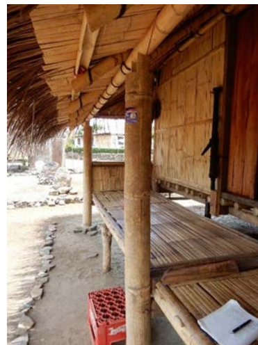
図6. Naggela村の災害後の臨時風土建築の軒下空間、ここでは、建造中の臨時建築の部品を作ったり、織物をしたり、ご飯を食べたりしている。臨時建築においても、作られるほど、軒下空間は大切にされている。本来の風土建築を立てるにはこれの三倍のお金が必要で村民は再建する意思はあるが、予算がない。風土建築でも何でもないコンクリートレンガ・トタン屋根建築ならこの臨時建築よりもっと安く建てられる。
