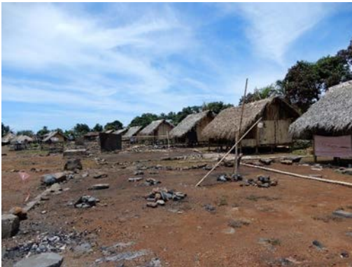
図5. 2018年11月11日未明に全焼し復興中のフローレス島、Lio族の村、一軒を除き全焼し、再建されたが、本来の風土建築ではなく臨時のもの。未明に起きた火災であることから、村人は電気火災だと推測している。この写真だけ見せると、Unfairなので、災害と風土建築について少し触れる。このように火災に対して弱い風土建築ではあるが、地震には強い。ロンボク島北部バヤン地区では強い地震が2018年夏に起こり、現代のコンクリートレンガ建築はほとんどすべての建築で全壊していたが、風土建築は少し傾くくらいで、一軒も壊れていなかった。
