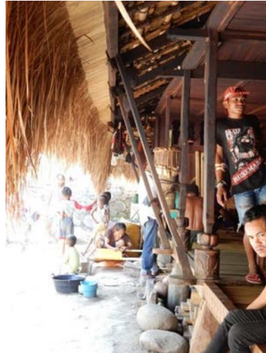
図 8. フローレス島、Lio 族の村 Wolo Topo の風土建築の軒下空間、談笑やゲームをするだけでなく、TV までもここにおいてあり、みんなで視聴していた。この建築が、火災していない村の Lio 族、本来の風土建築である。軒下空間において特徴的なのは、屋根から、チガヤが長く伸びており、太陽光を完全に遮断している。さらに、このチガヤにより、この軒下空間は遠くからは見られないようになっている。プライバシー意識（後述）の高い日本において、こうした建築構造は応用可能だと思った。
