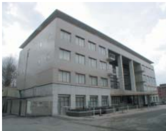
メディアセンター南館（OSL）建物
