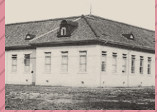
土木工学科以及机械工学科大楼 (1898年竣工)。1919年2月分科大学改名为学部。
