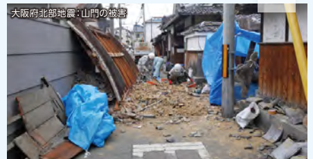
大阪府北部地震・山門の被害
