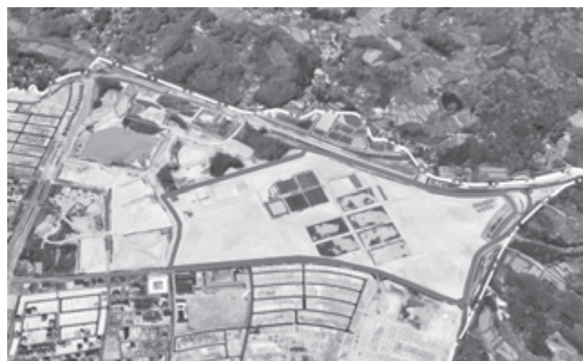
木津川新農場(中央部分)上空写真
