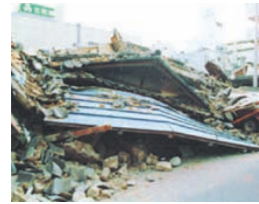
倒壊した木造家屋
