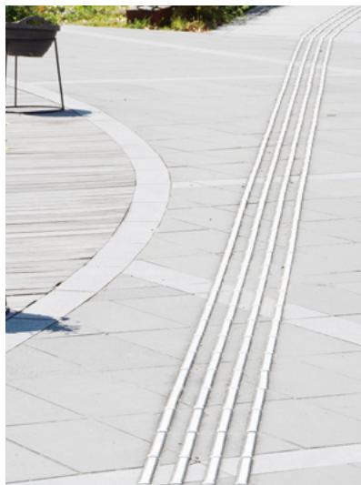
構内に設置された点字ブロック
