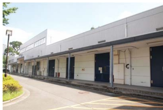
▲図4-5-8 総合研究実験棟(本部構内)
